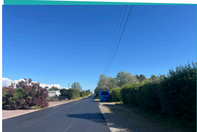
CHARRIÈRE DE LA CHEVROTIÈRE APRÈS TRAVAUX
