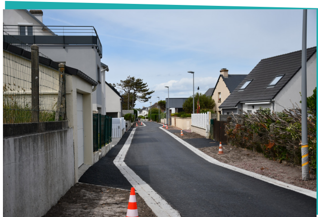
RUE DU GAILLARD D'AVANT APRÈS TRAVAUX
